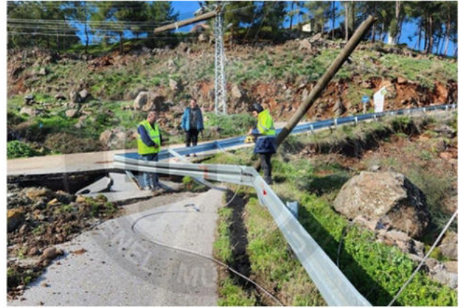
Kırıkhan - Hassa arasında, köy yolunda ve refüjde yüzey kırığı boyunca yaklaşık 2,5 metre sol yanal yer değiştirme - MTA deprem raporu
