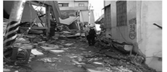
Şekil 5- Bina enkazlarıyla kapanan yol
