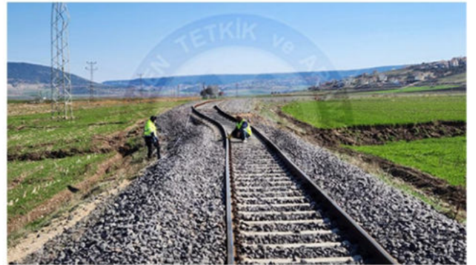
Narlı tren yolunda 270 cm sol yanal, 90 cm batı blok düştüğü deprem yüzey kırığı
