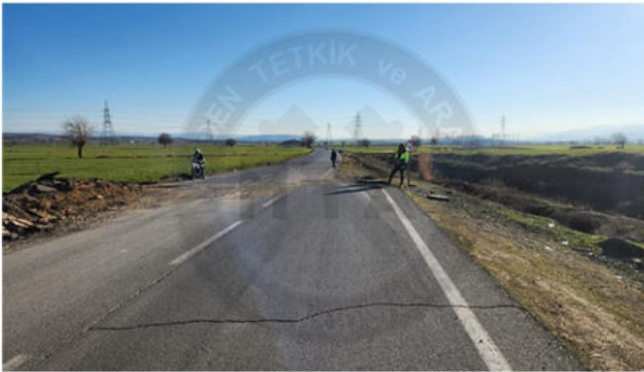
Pazarcık güneyi asfalt yolda 355 cm sol yanal yer değiştirme - MTA
